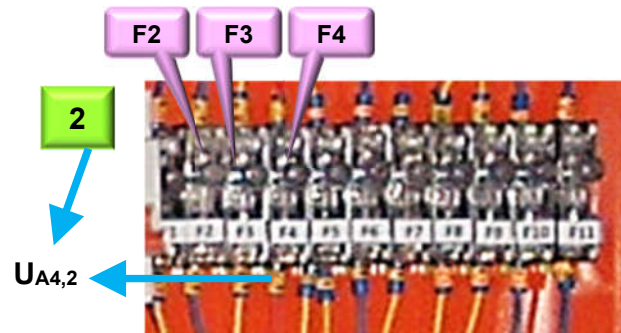
Hình 8.6: Đo điện áp ngõ ra các cầu chì F2, F3, F4
