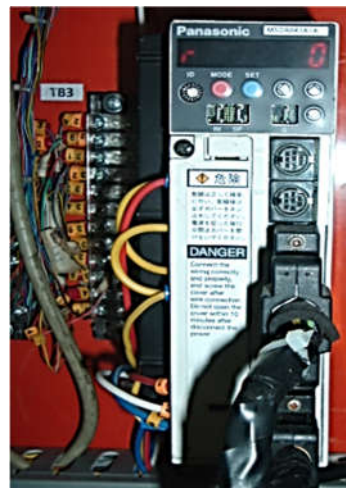
Hình 8.9: Kiểm tra hiển thị của bộ điều khiển động cơ Servo
